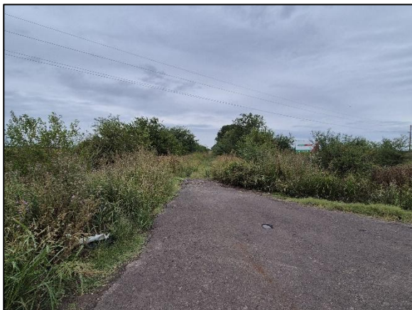
Figura 41 – Inicio traza Canal de Mihura, RPNº11 e intersección camino rural.
