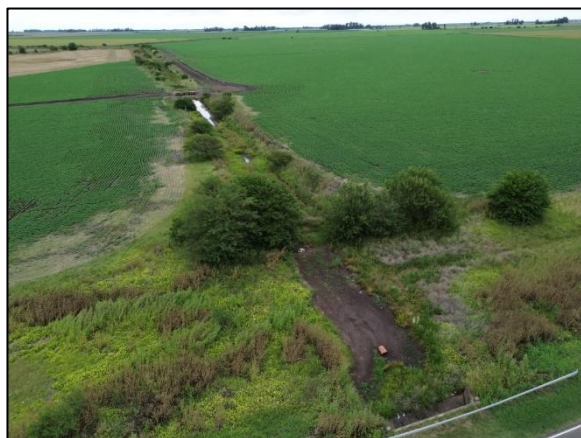
Figura 55 – Canal de Mihura, vista hacia sudoeste.
