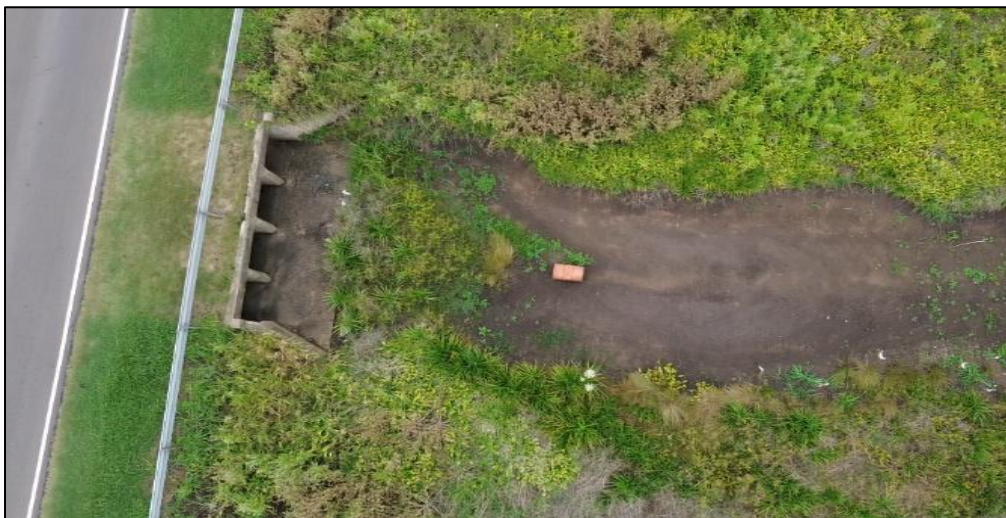
Figura 53 – Intersección del Canal de Mihura con la traza de la RPNº11. Se observa el puente existente.
