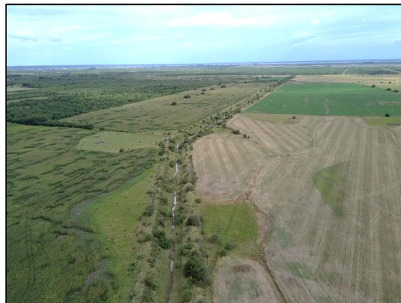
Figura 64 – Perspectiva aérea del Canal de Mihura (vista hacia el noreste). Se observa la configuración del terreno y el AID.
