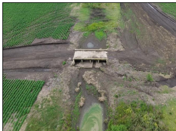
Figura 56 – Canal de Mihura, vista hacia sudoeste, vista estructura de alcantarilla.
