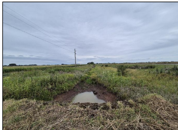
Figura 46 – Intersección del Canal de Mihura y punto de acceso a propiedad privada, vista canal hacia sudeste.
